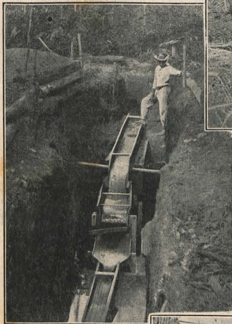
Un sluice, sorte de canal composé de plusieurs pièces appelées dalles où passent les terres aurifères avant d'abandonner leur or.
