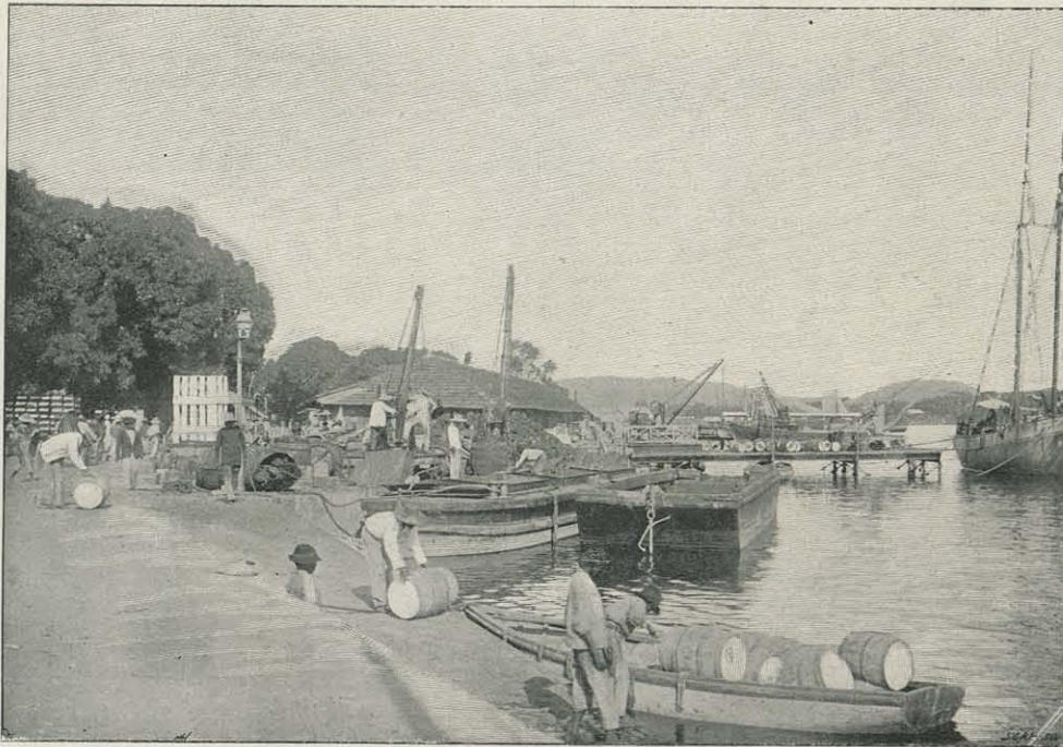
CAYENNE. — Aspect du port. — Vue générale du quai de déchargement
