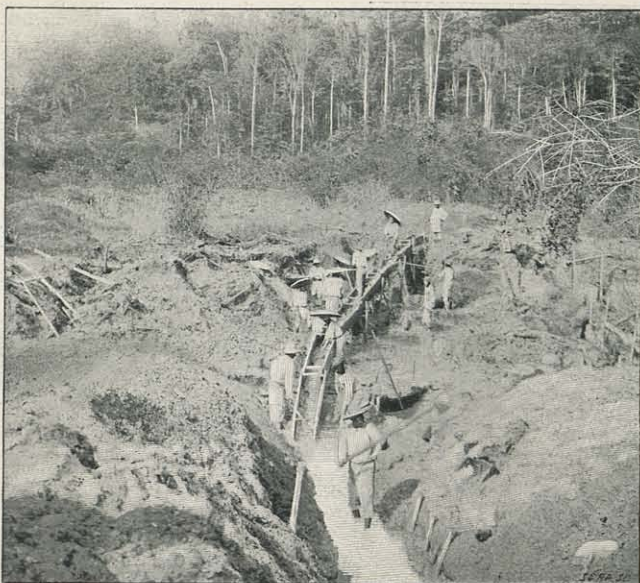
L'INDUSTRIE DE L'OR AU MILIEU DES SAVANES. — Lavage des terres aurifères dans des rigoles d'eau courante
