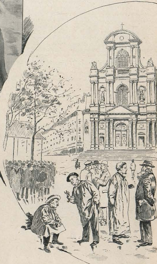
PLACE SAINT-GERVAIS. — Les maçons
