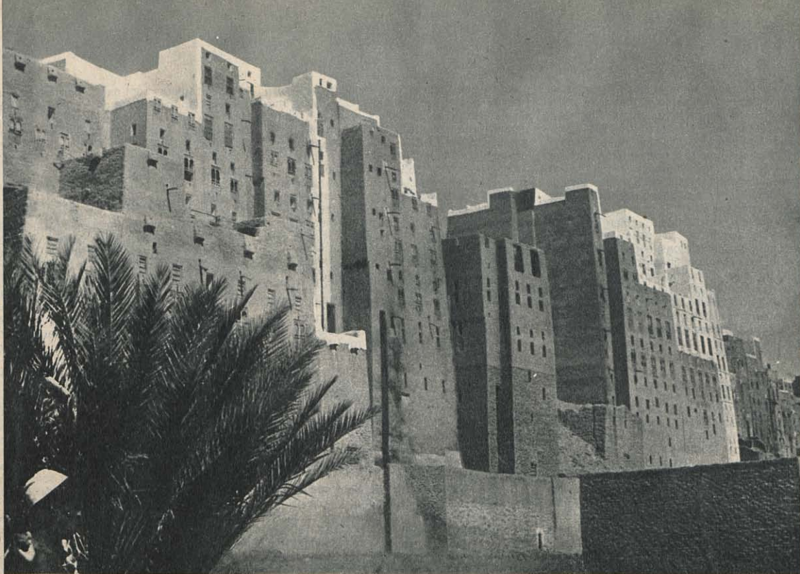
Et voici les étonnants gratte-ciel de Shibam, construits en boue séchée et fondations de pierre. Le nombre des étages paraît doublé par la rangée d'orifices d'aération qui surmonte chaque rang de fenêtres.
