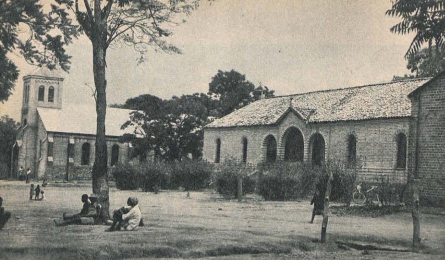
La « Mission » de Malolé comprend une église, une maison d'habitation pour les Pères Blancs, quelques communs et les cases de quelques fils de guerriers devenus fervents zélateurs.
