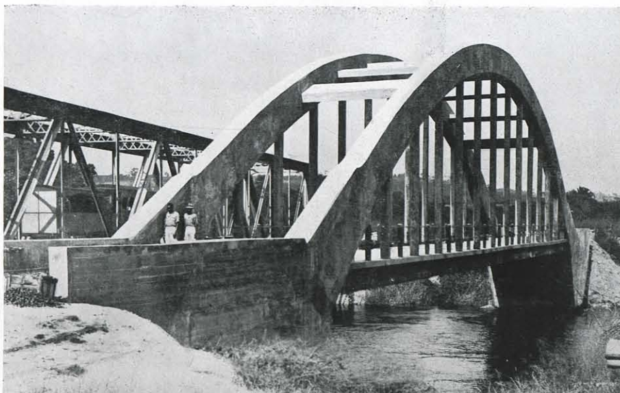
Le nouveau pont du chemin de fer sur le Djoué. Solide et trapu, il défiera les injures du temps.
