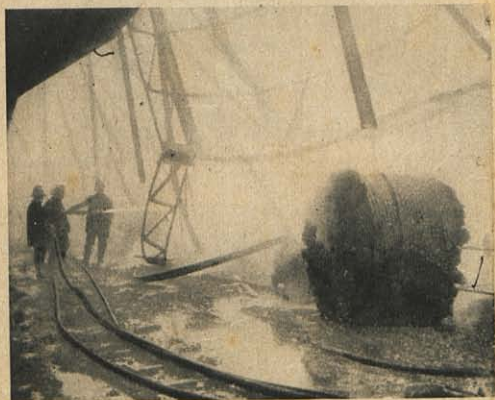
Un incendie a détruit la grande aile de la Centrale électrique de Bruxelles. L'incendie a été provoqué par l'explosion d'une des turbines.
