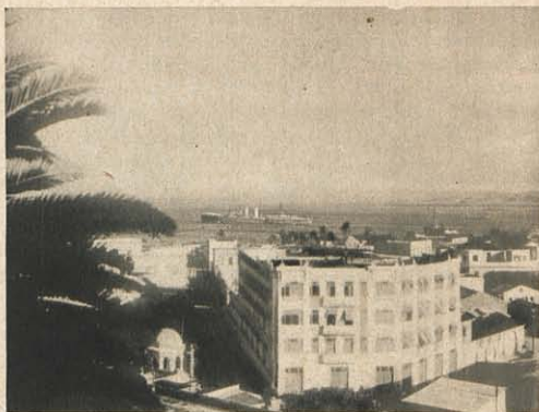
(Phot. Aginter.) Un des quartiers de San-Juan qui fut éprouvé par la tornade.
