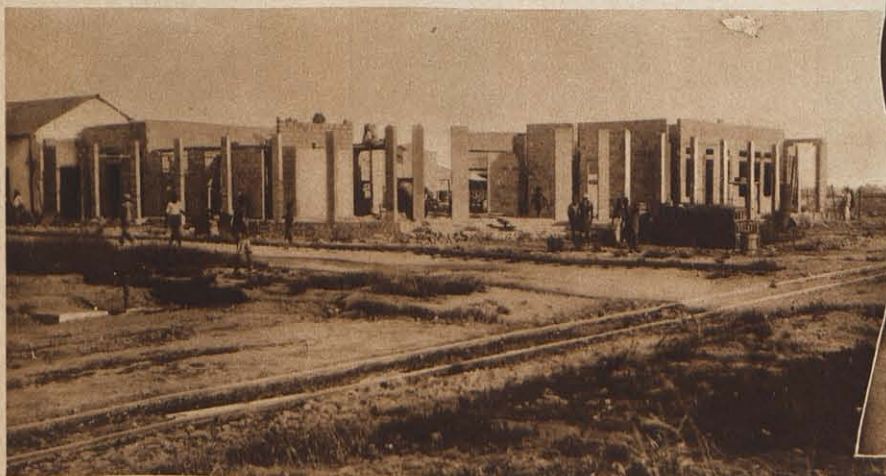
Pointe-Noire est un vaste chantier où les maisons sortent du sable blanc comme des champignons après la pluie.
