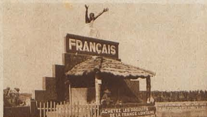
Curieuse signalisation de la descente dangereuse de Flin, sur la route de Paris à Deauville, sous forme de propagande coloniale. PHOTO A. BRAULT
