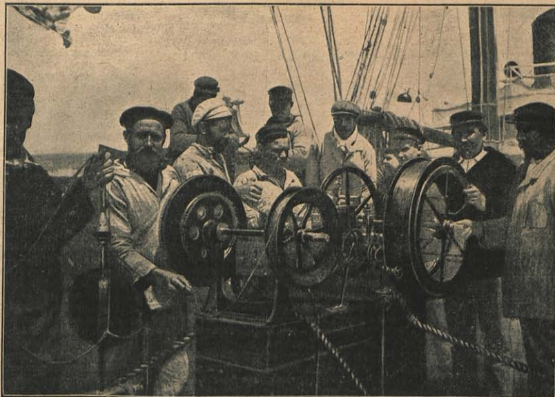
UN SONDAGE. — UN FIL MINCE EN ACIER, QUI N'A PAS MÊME UN MILLIMÈTRE DE DIAMÈTRE, VA DESCENDRE AU FOND DE L'EAU ET RAMENER, DE PLUSIEURS KILOMÈTRES, UN ÉCHANTILLON DU FOND.
