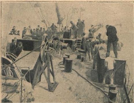
L'AVANT DU «FRANÇOIS ARAGO». — LA POSE EST TERMINÉE. ON VA COUPER LE DERNIER FILIN QUI RATTACHE ENCORE LE CÂBLE À BORD.
