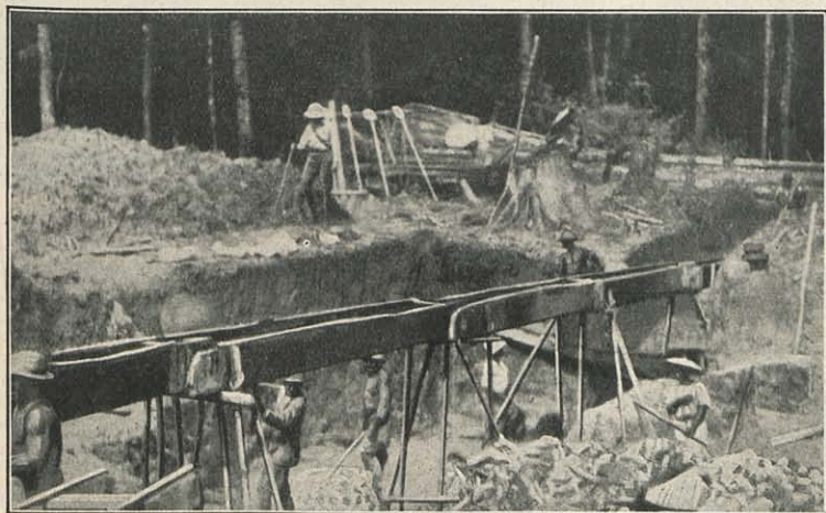
CONSTRUCTION D'UN SLUICE PORTATIF EN PARTIE MONTÉ SUR DES CHEVALETS
