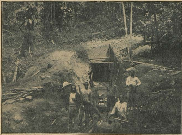
UN TUNNEL DE PROSPECTION POUR GISEMENTS AURIFÈRES.
