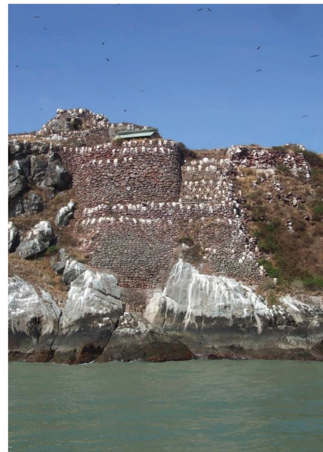
Vue d'ensemble de la zone de départ des bennes, avec un important ouvrage de soutènement murailé
