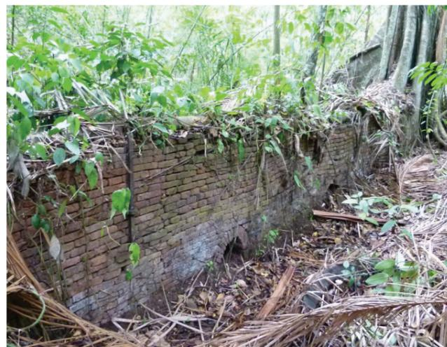
Fig. 39 Vue du tunnel en chauffe à l'anglaise de la sucrierie
