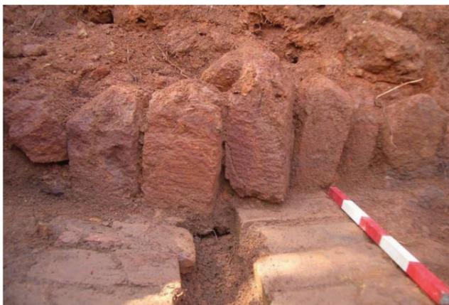
Fig. 20 Vue des clavaux posés sur la canalisation
