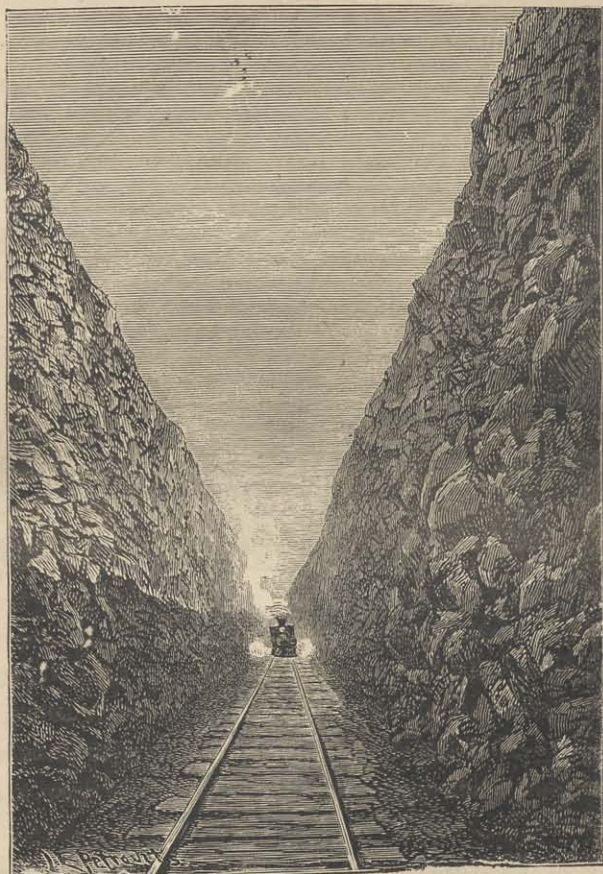
FIG. 173. — VOIE DU CHEMIN DE FER DE L'ÉRIÉ, DE 1 m ,83 DE LARGE
