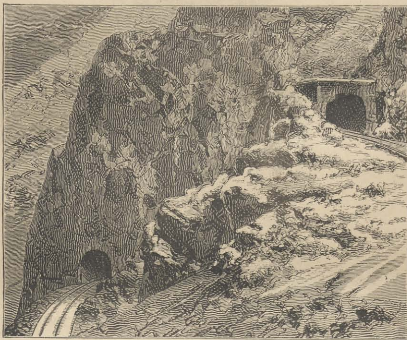
Fig. 186. — DEUX TUNNELS SUR LE CHEMIN DE FER DES CORDILLÈRES DES ANDES (LIMA-OROYA)
