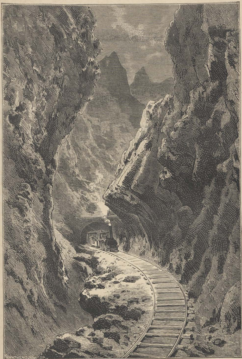
FIG. 224. — ENTRÉE DU GRAND TUNNEL DANS LA SIERRA NEVADA.
