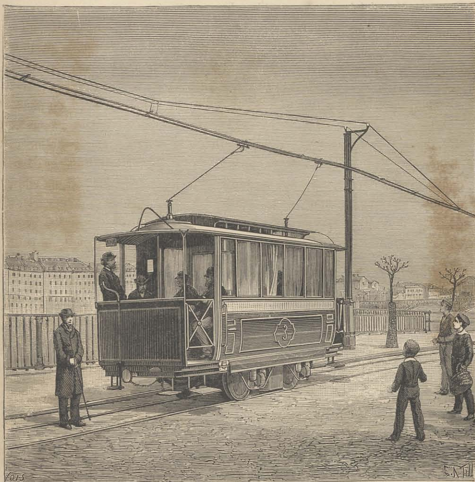
Fig. 117. — WAGON DU CHEMIN DE FER ÉLECTRIQUE DE SACCHAUSEN A OFFENBACH
