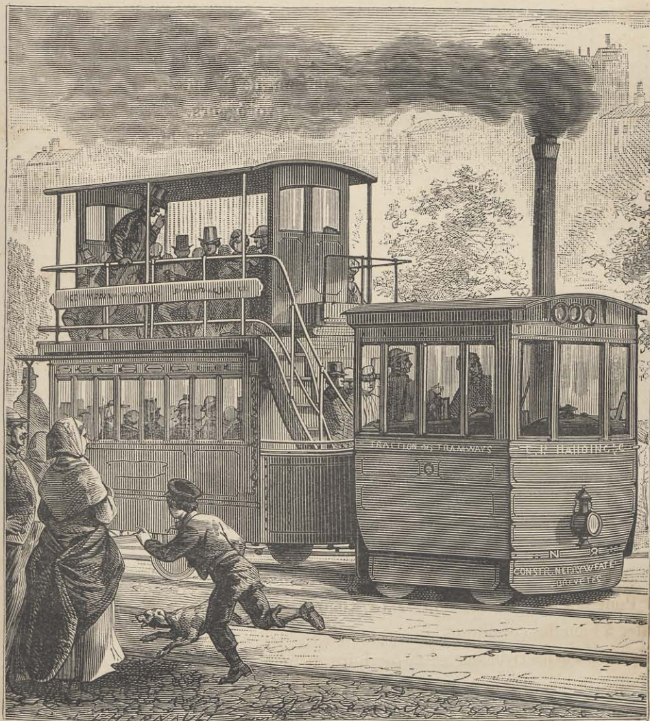
FIG. 92. — REMORQUEUR A VAPEUR POUR LES VOITURES DE TRAMWAYS EXPÉRIMENTÉ A PARIS, SUR LA LIGNE DE SAINT-DENIS
