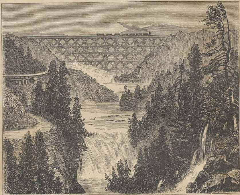
FIG. 478. — ANCIEN VIADUC EN BOIS, DE PORTAGE
