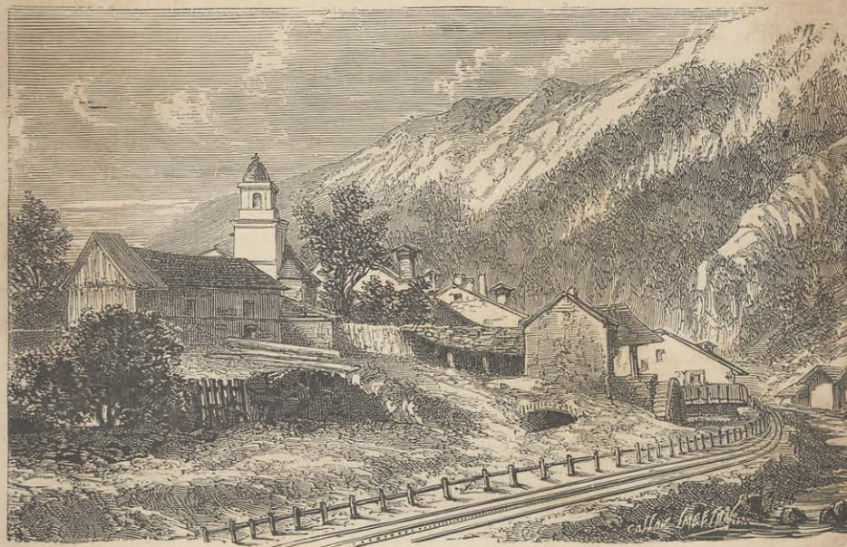
FIG. 23. — LANS-LE-BOURG, SUR LA ROUTE DU MONT CENIS Voie à crémaillère posée pour l'essai du système de traction funiculaire de M. Agudio.
