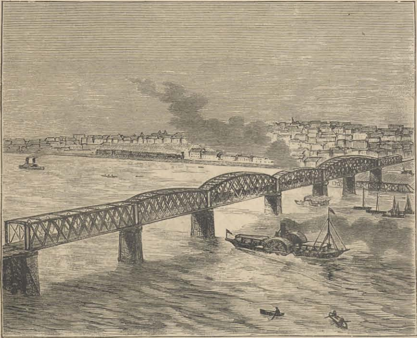
FIG. 179. — PONT EN TREILLIS DE FER DE KANSAS-CITY, SUR LE MISSOURI
