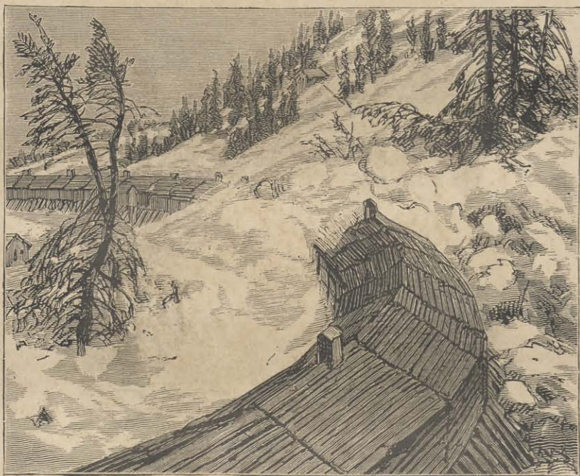
FIG. 191. — ABRI CONTRE LES AVALANCHES, SUR LE CHEMIN DE FER DU PACIFIQUE, DANS LA SIERRA NEVADA
