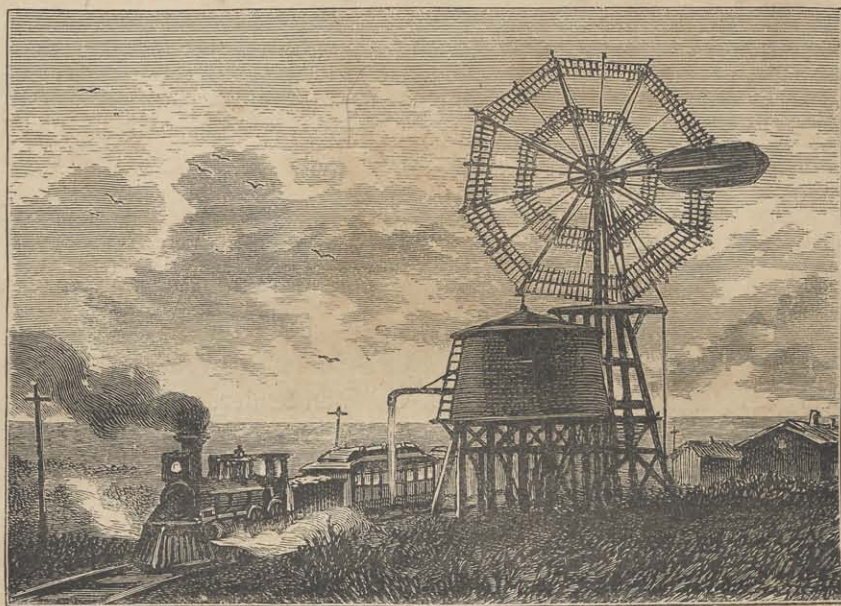
FIG. 207. — MOULIN A VENT POUR ÉLEVER L'EAU DANS LA TOUR HYDRAULIQUE
