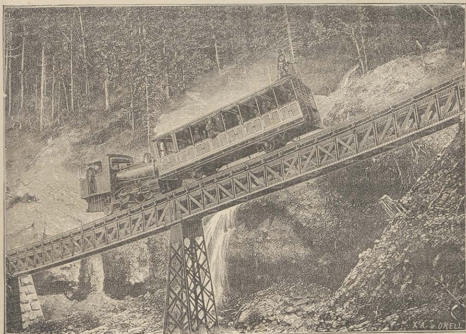
FIG. 68. — PONT DE ROTHENFLUH
