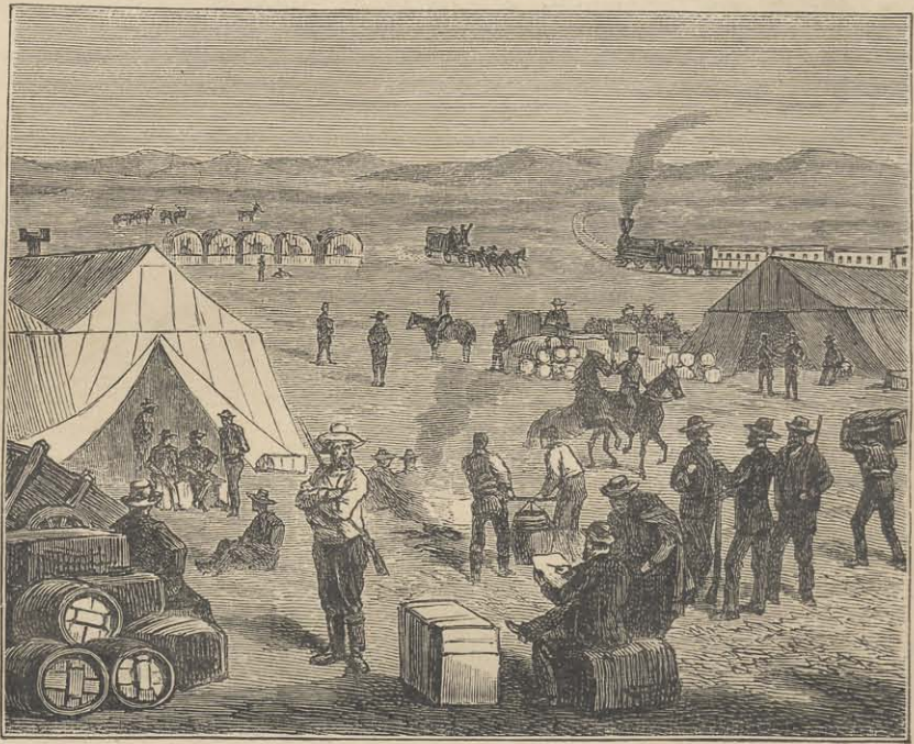
FIG. 211. — LE CHEMIN DE FER DU PACIFIQUE PENDANT LES TRAVAUX SUR LE TERRITOIRE INDIEN
