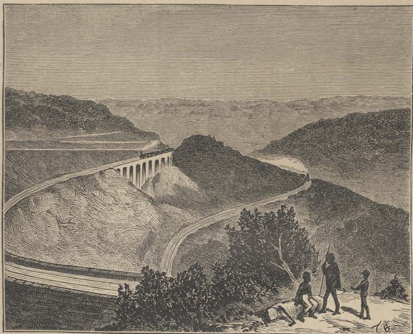
FIG. 260. — LE GRAND ZIGZAG, OU LA DOUBLE VOIE COURBE DU CHEMIN DE FER, DANS LES MONTAGNES BLEUES (AUSTRALIE).
