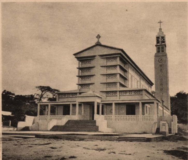
Eglise du Morne-à-l'Eau (11.628 hab.) — Vue extérieure. Construction récente et de style moderne. Le clocher mesure 40 m. 70.
