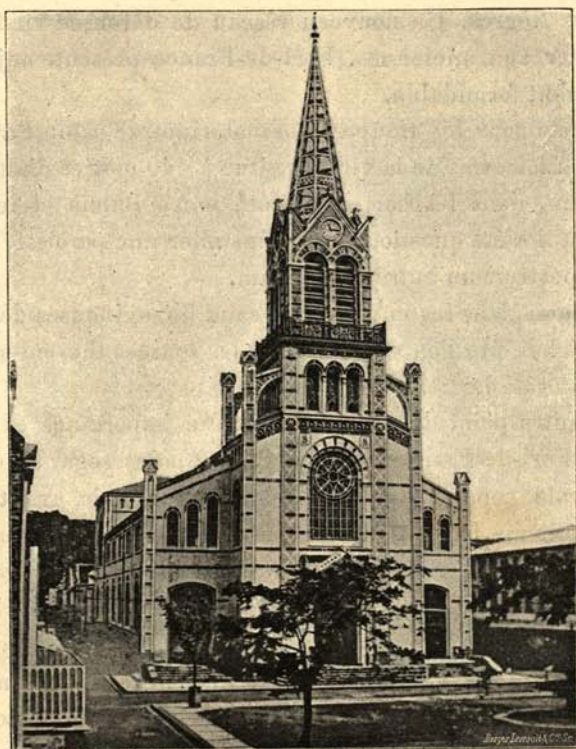
LA NOUVELLE CATHÉDRALE DE FORT-DE-FRANCE
