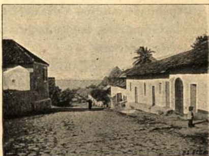
HABITATION PERRINELLE. — QUARTIER DES NÈGRES.
